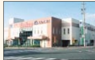
金谷支店 平成12年10月16日新築移転
