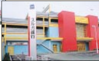
伊豆中央支店 平成12年10月10日新築移転
