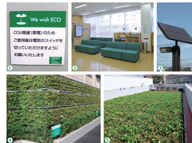
①ECO啓発掲示板 ②LED照明 ③ソーラー発電外灯 ④壁面緑化 ⑤屋上緑化
