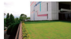
屋上緑化(スルガ平本部)
