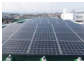
太陽光発電パネルの屋上設置
