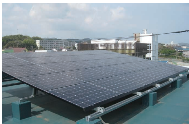
太陽光発電パネルの屋上設置
