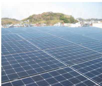
太陽光発電パネルの屋上設置
