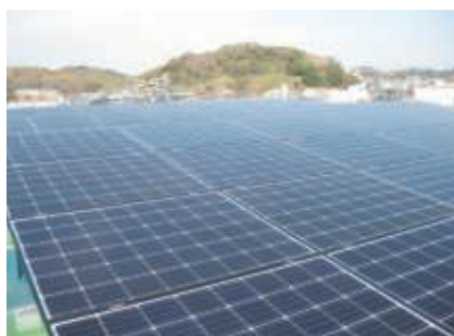
太陽光発電パネルの屋上設置
