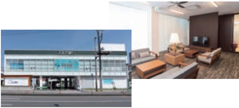
＜清水支店のエコオフィス化＞ 左：外観（Ecoガラス） 右：LED照明とシーリングファン
